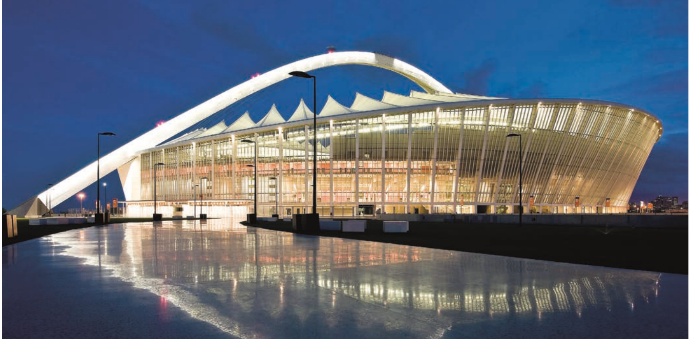
Moses Mabhida Stadion in Durban: Pfeifer war für die Dachkonstruktion verantwortlich.
