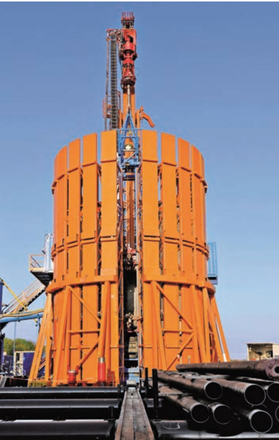
Bohranlage von Daldrup: Sie dringt in Tiefen von bis zu 4.500 Metern vor.
